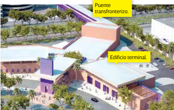
Foto: Especial Se prevé que en octubre quede concluida la obra del puente y el edificio terminal, de modo que en diciembre inicie el servicio.
